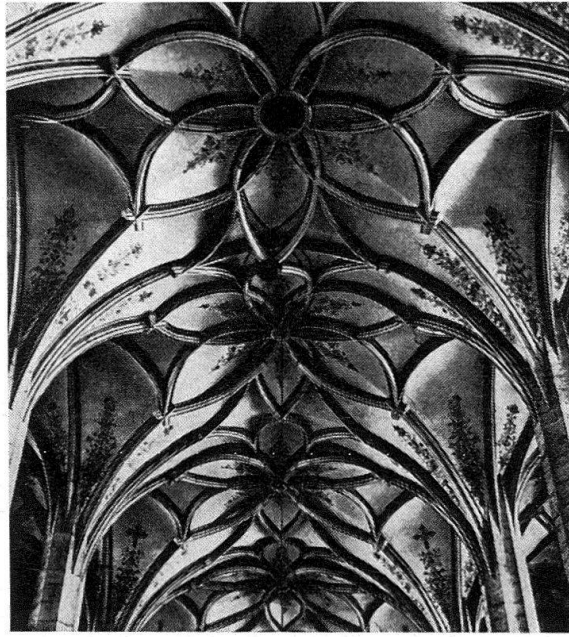
Abb. 2. Blick in das Rosettengewölbe des Mittelschiffs
