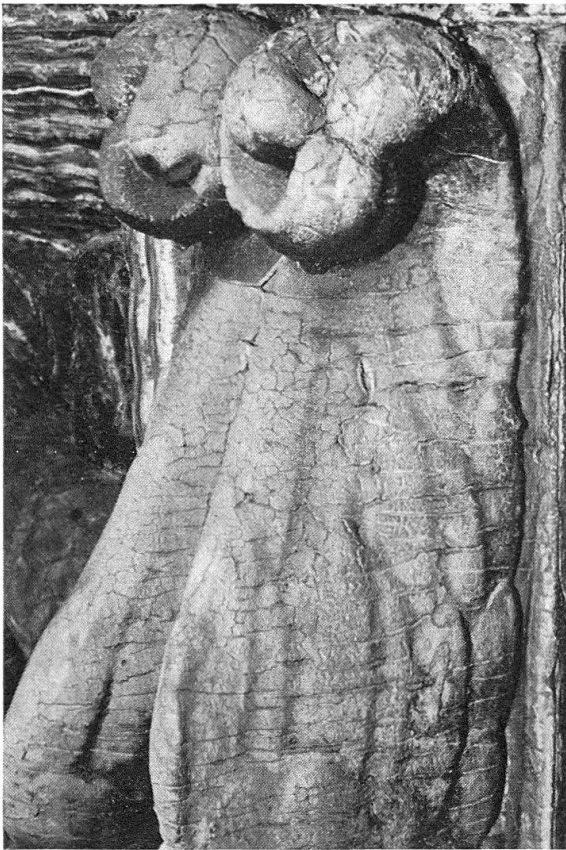
Abb. 4. Haus «Zum Schwanen», Engelsflügel. Schnitzwerk durch bis zu fünf Fassungen vollständig verdeckt. Farbschichten mit vielen Rissen und zum Teil abblättern
