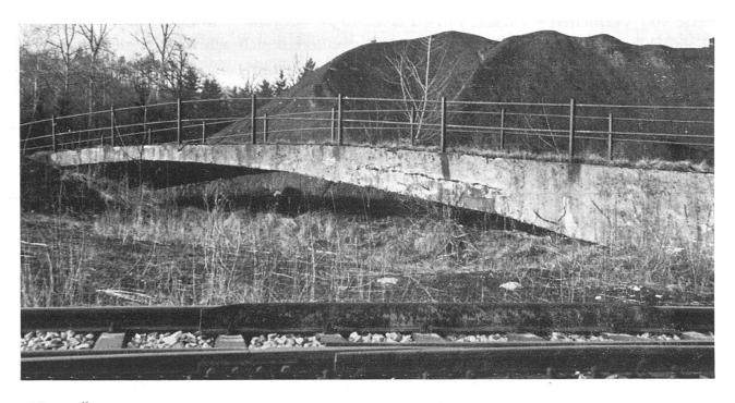
Abb. 3. Über einem zugeschütteten Fabrikkanal in Wildegg fristet die erste Eisenbetonbrücke der Schweiz ihr Dasein. Sie wurde 1890 mit 27,22 m Spannweite und 20 cm Scheiteldicke errichtet
