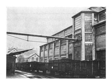
Abb. 10. Die billige Bauweise des Eisenbetonbaues eroberte vor allem den Industriebau. 1904–08 wurde das Gaswerk Schlieren erweitert. Als Pionierleistung beeindruckt der Kohlenschuppen des Werkes (Gebr. Rank aus München) auch heute noch
