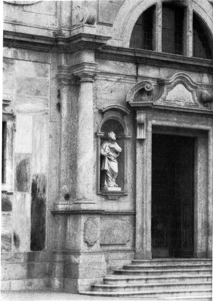
Mittelpartie der Fassade aus grobkörnigem Bergeller Granit. Gesimse und Schilder aus feinerkörnigem, dunklem Tonalit. Die Plastik besteht aus dem lichten Kalkstein von Saltrio (wie die Fassade von San Lorenzo in Lugano)
