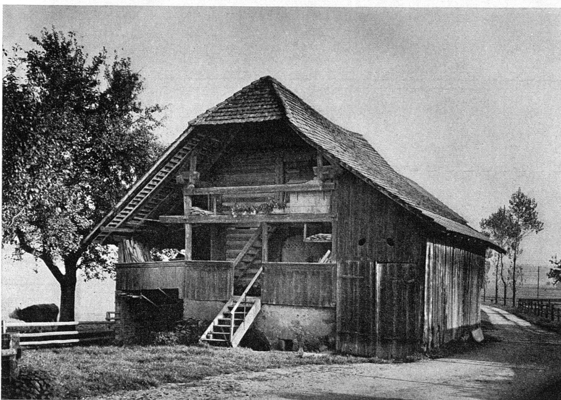
Bauten-Test Aetingen SO. Abb. 5. Bauernhaus Andres (1838), stattliches, fast intaktes «Rieghaus» mit gleichzeitiger Scheune. – Abb. 6. Speicher Messer (1700), Hälbling-Ständerbau, schöne Details, leider durch Wagenschöpfe beeinträchtigt
