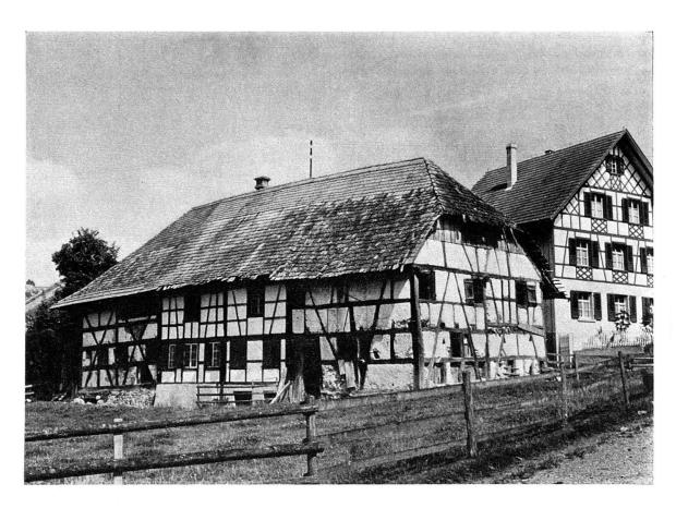
Abb. 1. Vielzweckbau in Fachwerk-Bauweise mit Walmdach, im Wirtschaftsteil rechts sind durchgehende Ständer und Langstreben sichtbar. Ueßlingen TG
