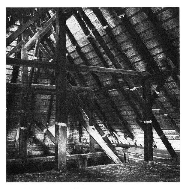
Abb. 3. Dachgerüst eines Mehr-Ständerreihenhauses, das die Vereinigung der Hochstudelemente (Firstständer, Firstpfette, Unterfirst, Windstreben) mit Zwischenständern (Mittelpfette tragend) und Kehlbalken zeigt. Die ursprüngliche Rafenlage, Dachlatten und Strohbelag sind noch erhalten (Strohdach erneuert). Hüttikon ZH, 1652
