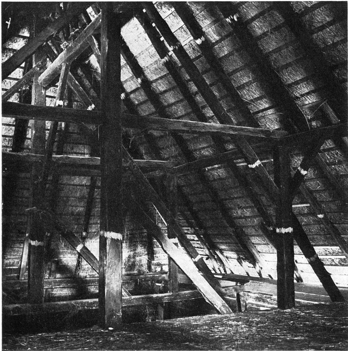
Abb. 3. Dachgerüst eines Mehr-Ständerreihenhauses, das die Vereinigung der Hochstudelemente (Firstständer, Firstpfette, Unterfirst, Windstreben) mit Zwischenständern (Mittelpfette tragend) und Kehlbalken zeigt. Die ursprüngliche Rafenlage, Dachlatten und Strohbelaag sind noch erhalten (Strohdach erneuert). Hüttikon ZH, 1652
