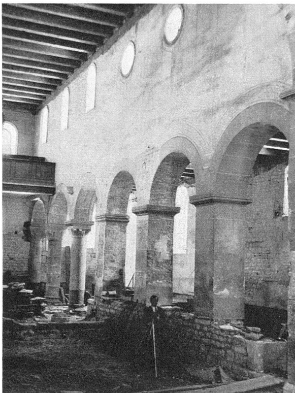
Abb. 4. Feldbach. Blick von SO nach NW in das Hauptschiff. Durchlaufende Mauer unter späteren Pfeilern, nur Säulenarkaden alt
