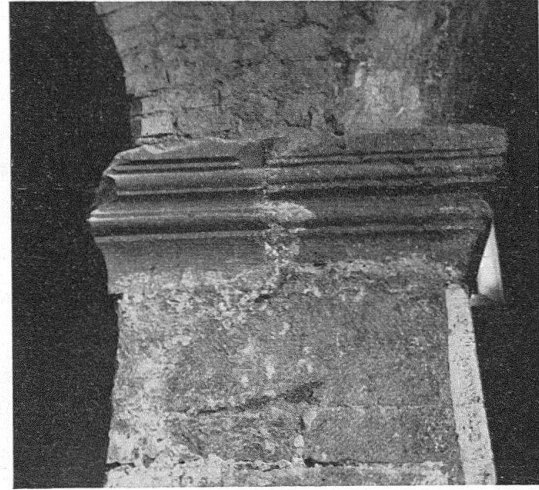
Abb. 4. Feldbach. Blick von SO nach NW in das Hauptschiff. Durchlaufende Mauer unter späteren Pfeilern, nur Säulenarkaden alt
