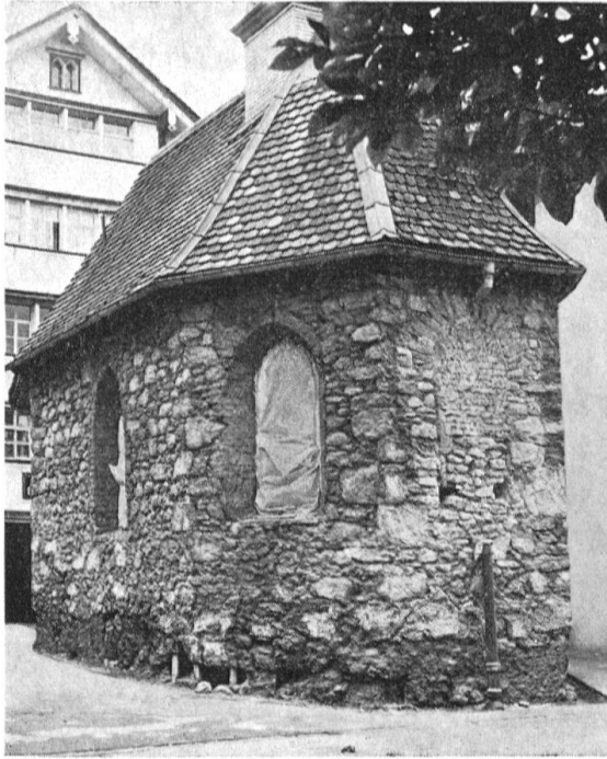
Appenzell. Kreuzkapelle. Äußeres während der Restaurierung nach Abschlagen des Verputzes und Inneres mit dem (inzwischen entfernten) hölzernen Abschlußgitter
