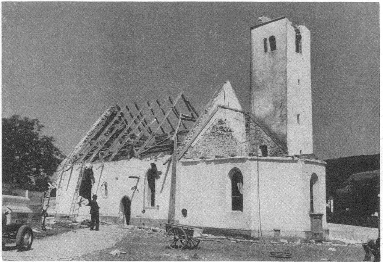
Kriegsruine? Nein, die 1949 abgebrochene Landpfarrkirche von Möriken
