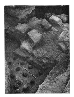
Pfahlwerk unter dem Fundament des ersten Baus, Ende 11. Jh.
