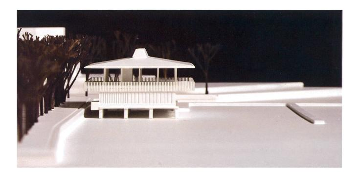
statische Höhe des Walmdachs ist nichts anderes als eine architektonische Lösung, um die notwendigen Kamine und Entlüftungsrohre in eine architektonische Form zu bringen. Diese fünfte Fassade spielt in Luzern eine entscheidende Rolle, da die umliegenden Bereiche auf das Dach des Seerestaurants blicken.
