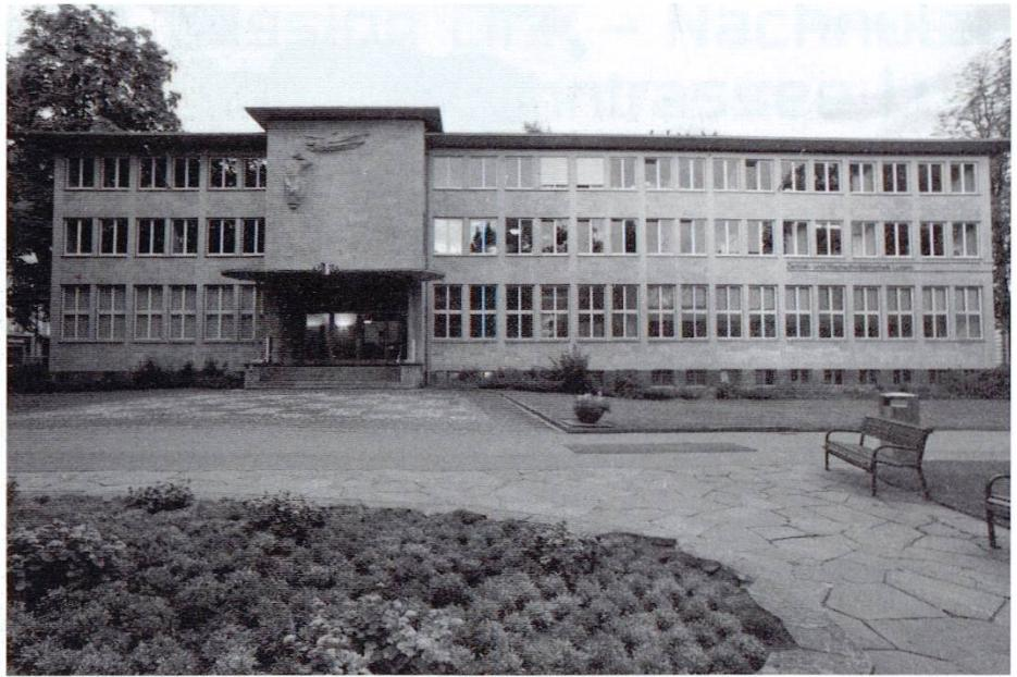
durch minimalen Platzbedarf bezüglich Durchgangsbreite und Geschoss Höhe. Die festverglasten Betonsprossenfenster bringen Licht in das Bücherlager. Als Ingenieur setzte Rudolf Dick die Vorstellungen von Otto Dreyer um.
