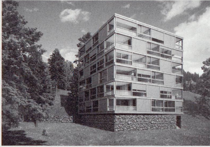
Auf der Rigi entstanden im Wechsel der Generationen neue Bautypen. 1953 folgte auf den Abbruch des Grand Hotels Schreiber der einem Hospiz nachempfundene Neubau von Max Kopp. Das aktuelle Projekt Bellevue Rigi-Kaltbad stammt von Lischer Architekten Luzern.
