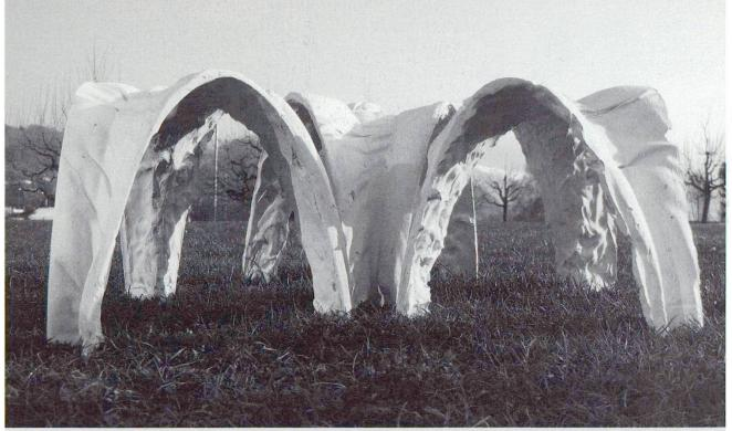
auf möglichst dünnwandige Betonkonstruktionen. Es lag deshalb nahe, sich mit textilen Bewehrungen in Form von Geweben und Fasern auseinanderzusetzen. Durch das Wegfallen der bei Stahlbeton relevanten Korrosionsproblematik und der damit verbundenen Betonüberdeckung bot diese Konstruktionsart die Möglichkeit geringer Materialstärken von etwa 20 mm.
