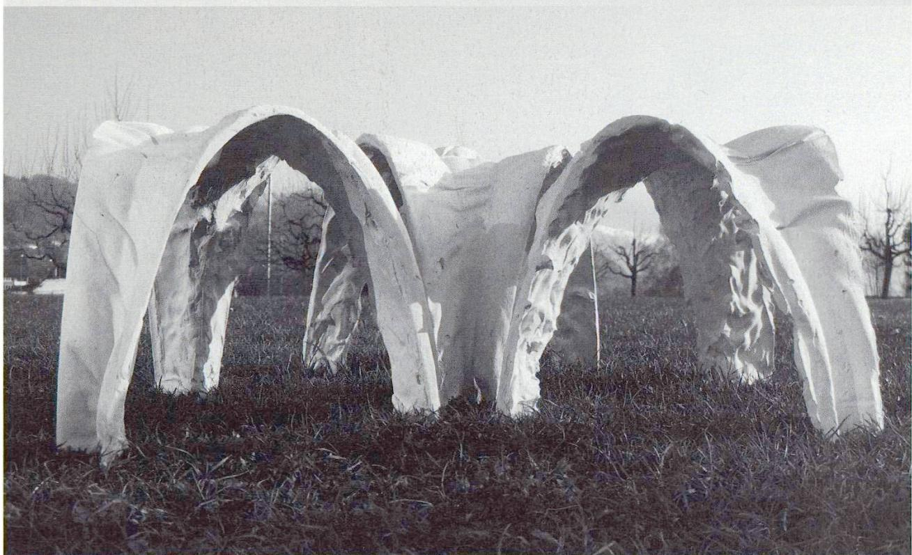
auf möglichst dünnwandige Betonkonstruktionen. Es lag deshalb nahe, sich mit textilen Bewehrungen in Form von Geweben und Fasern auseinanderzusetzen. Durch das Wegfallen der bei Stahlbeton relevanten Korrosionsproblematik und der damit verbundenen Betonüberdeckung bot diese Konstruktionsart die Möglichkeit geringer Materialstärken von etwa 20 mm.
