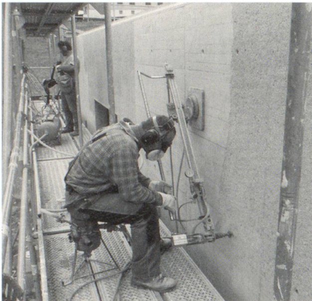
Fassadengestaltung beim Primarschulhaus Unterlöchli in Luzern: der Beton wird gestockt.
