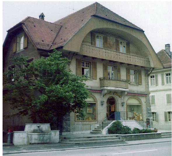
Zwei Treppenarme seitlich und Stufenplateau.
