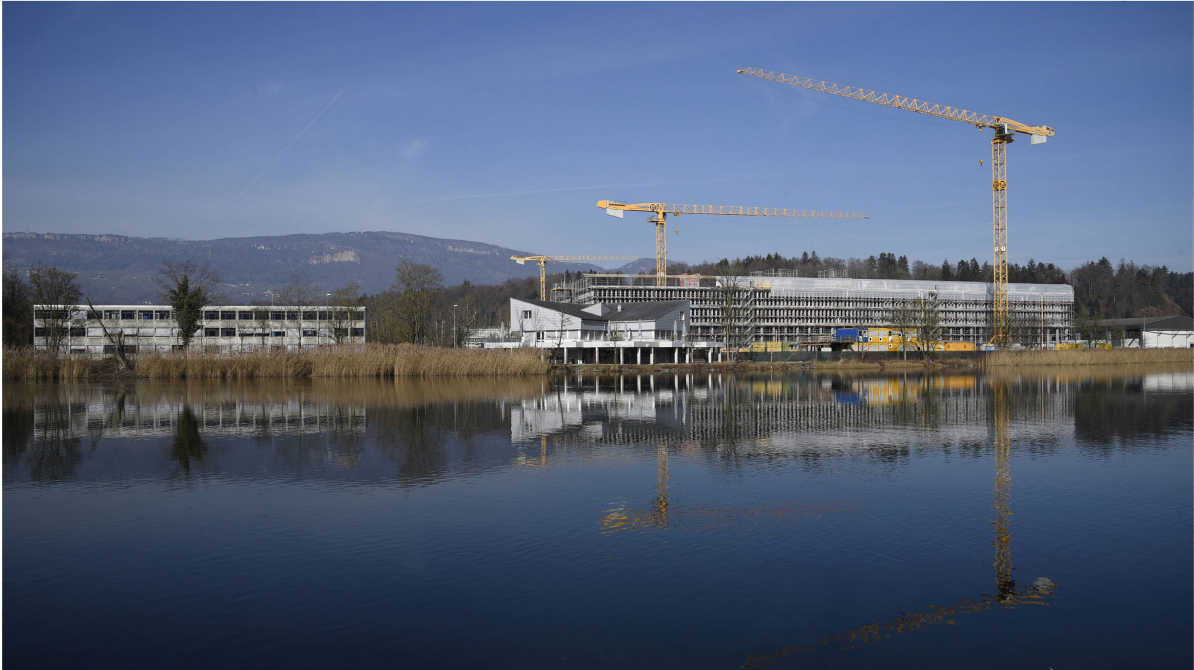
Der neue Waffenplatz ist im Entstehen (Foto vom Febr. 2023). V.l.n.r.: Alte Kaserne, im Hintergrund das neue WAM, das Restaurant ‚Fischermatte‘ an der Aare, die neu entstehende Rettungskaserne (Aarekaserne), ganz rechts die Mehrzweckhalle. Foto mh.
