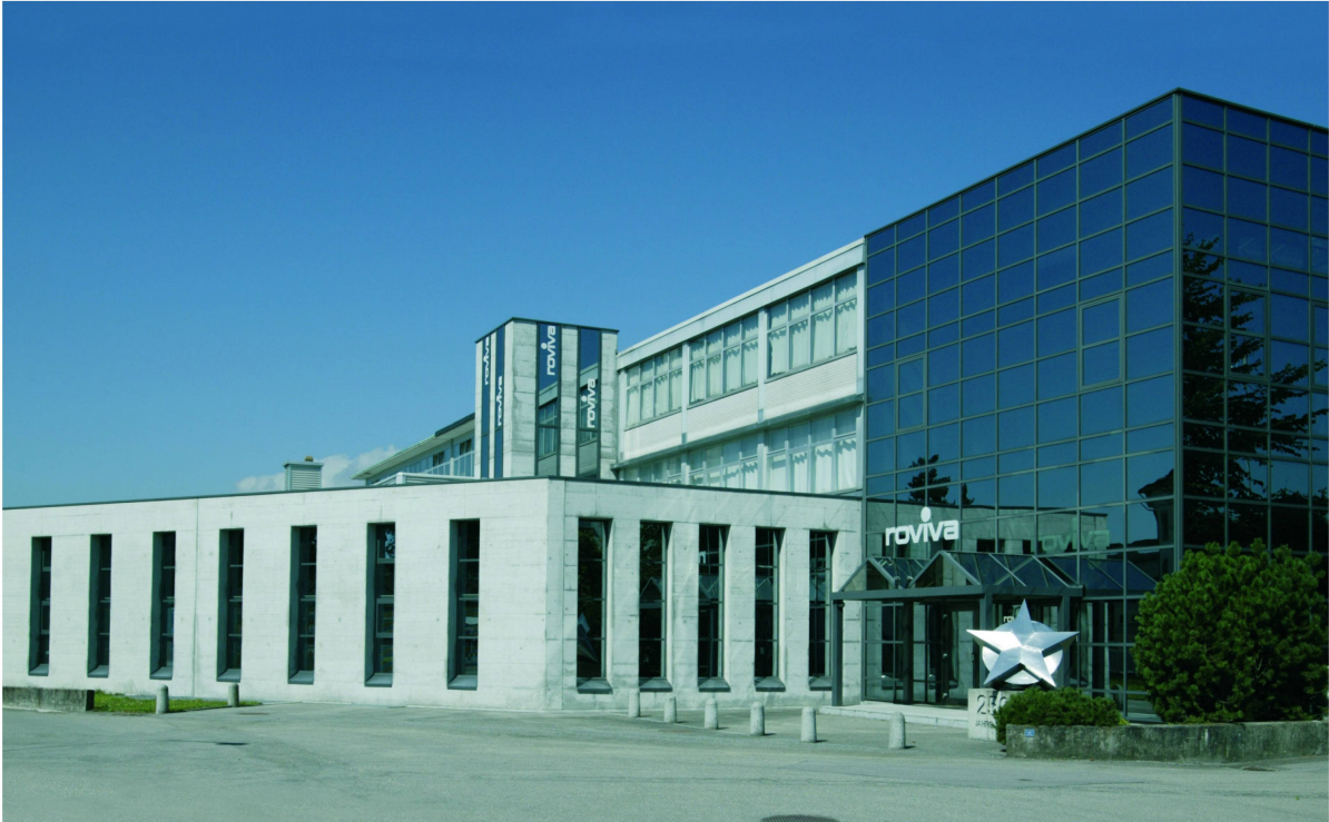
Südsicht der roviva Matratzenfabrik heute.
