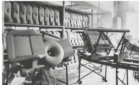
Formenkarussell mit Autositzen in der PU-Schäumerei.
