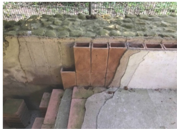
Abb. 3 Heizröhren «Tubuli» um die Wand zu beheizen. Beispiel einer beheizbaren Wand bei der römischen Badeanlage Engehalbinsel Bern.
