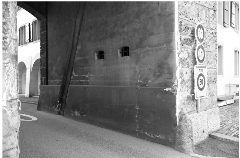
Linkes Foto: v.l.n.r. Südeingang des Torbogens für die Fahrzeuge, in der Innenecke die geschlossene Eingangstür zum Pissoir, Fussgängerpassage. Rechtes Foto: Innenseite des Torbogens mit den zwei Belüftungsfenstern des Pissoirs, weiter nach Innen die schräge Kerbe des Fallgatters.
