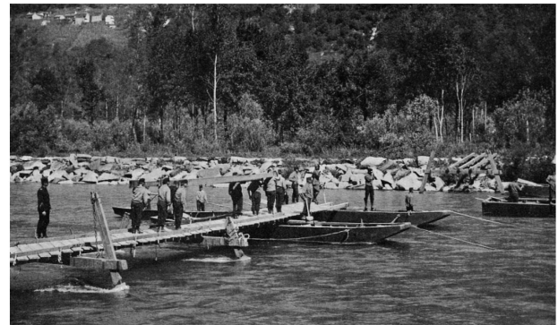
Divisionsbrückentrain 3. Kommandant: Hauptmann Schürch. Brückensteg mit schwimmenden (Pontons) und festen (Böcken) Unterstützungen. Einbau der Pontons. Bau eines 72 m langen Brückensteiges für Infanterie und leichte Fuhrwerke.
