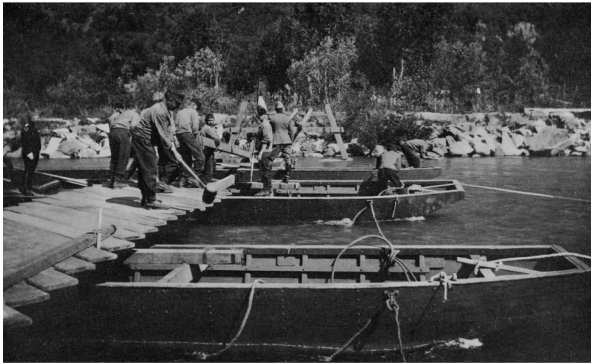
Divisionsbrückentrain 3. Kommandant: Hauptmann Schürch. Brückensteg mit schwimmenden (Pontons) und festen (Böcken) Unterstützungen. Einbau der Pontons. Bau eines 72 m langen Brückensteges für Infanterie und leichte Fuhrwerke.
