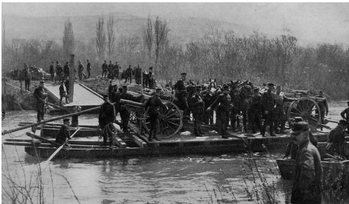
Hier wurde von den Pontonieren eine ‚fliegende‘ Brücke oder Fähre eingerichtet, welche zwei Kanonen, zwölf Pferde und die dazu gehörende Mannschaft übersetzt.
