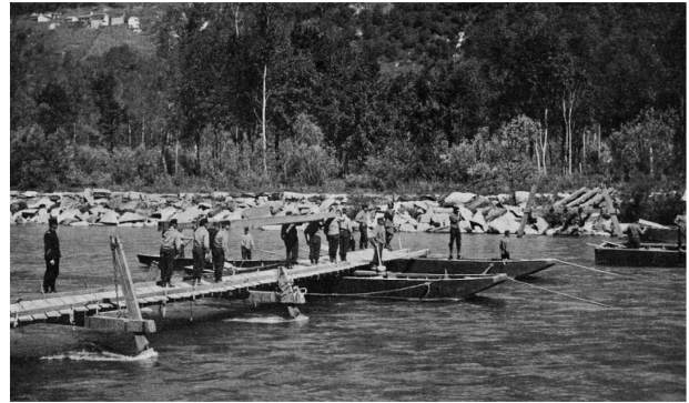
Divisionsbrückentrain 3. Kommandant: Hauptmann Schürch. Brückensteg mit schwimmenden (Pontons) und festen (Böcken) Unterstützungen. Einbau der Pontons. Bau eines 72 m langen Brückensteges für Infanterie und leichte Fuhrwerke.
