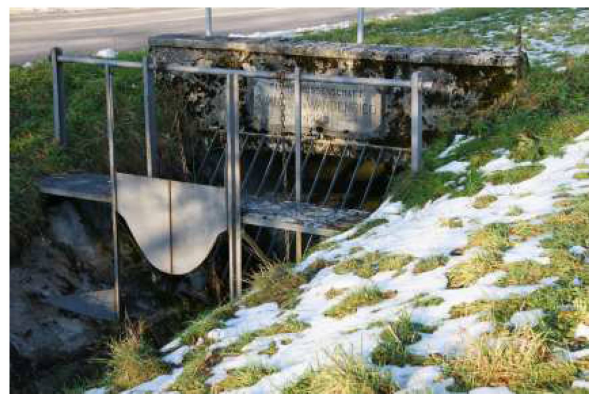
Entwässerungskanal und Eiformleitung bei der Oesch (früher OAK). ‚Flurgenossenschaft Wangen-Wangenried 1923‘.
