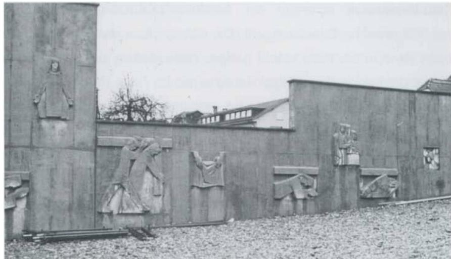
*Der Bildhauer brachte die Figuren in Form von Gipsnegativen auf den Bau, wo sie etappenweise in die Schalung eingebaut und mit der Wand ausbetoniert wurden. Am nächsten Tag wurden die Gipsmodelle mit Sorgfalt abgeschlagen, die Spannung bei den Arbeitern war jeweils gross, bis sich zeigte, dass das Werk gelungen war. Die Herstellung dieses Reliefs direkt mit der Mauer betoniert, nicht eingesetzt, war damals für die Schweiz einmalig.*
