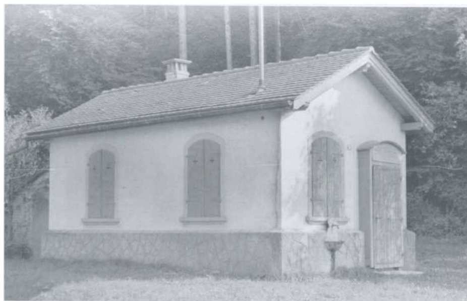
das alte Pumpenhaus
