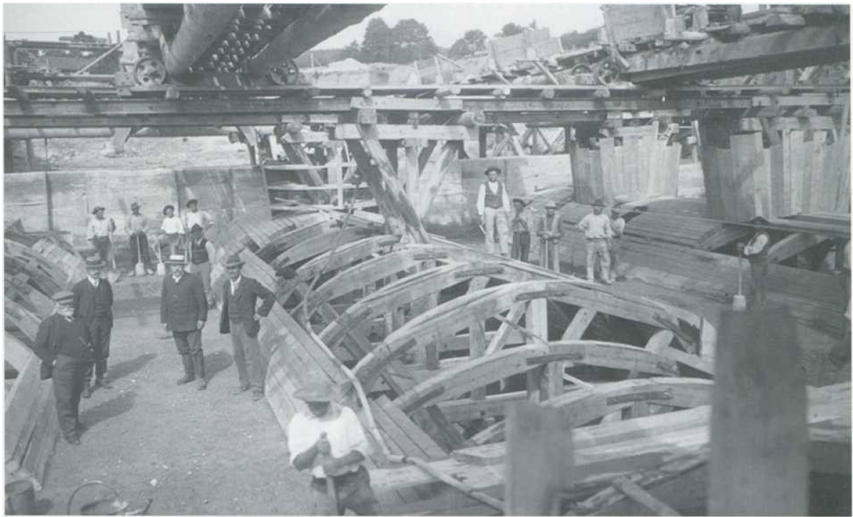
Maschinenhaus, Einschalung und Betonierungsarbeiten der Gewölbe 10. Juli 1903
