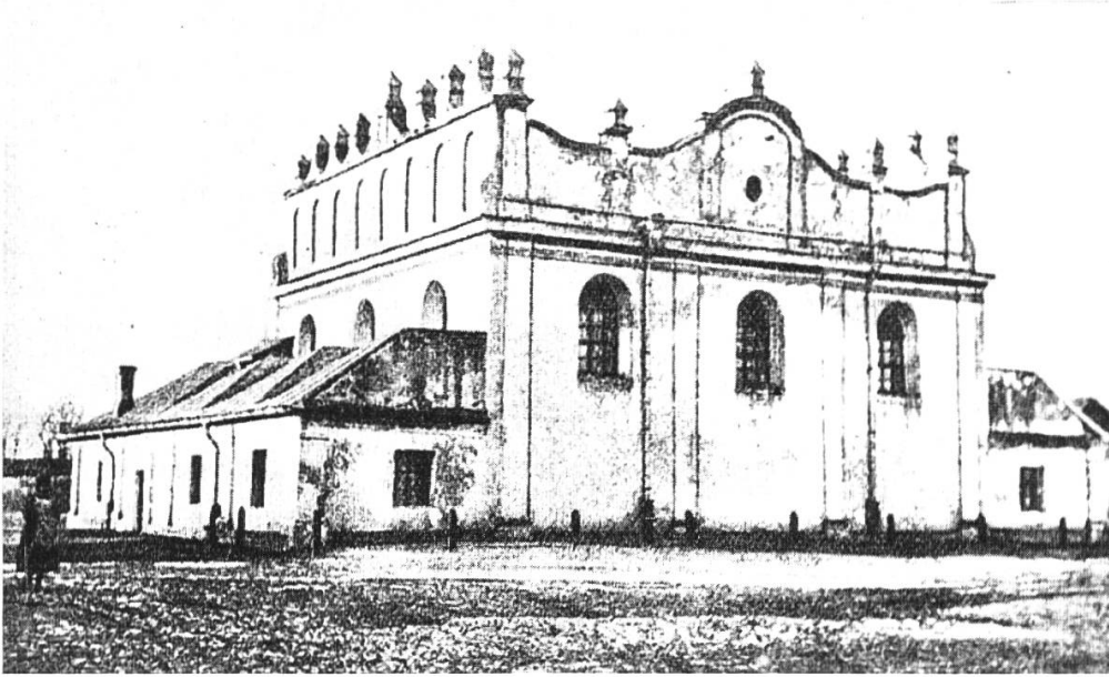
Abb. 4. Aussenansicht der Synagoge in Leszniów von Südosten, vor 1936.
