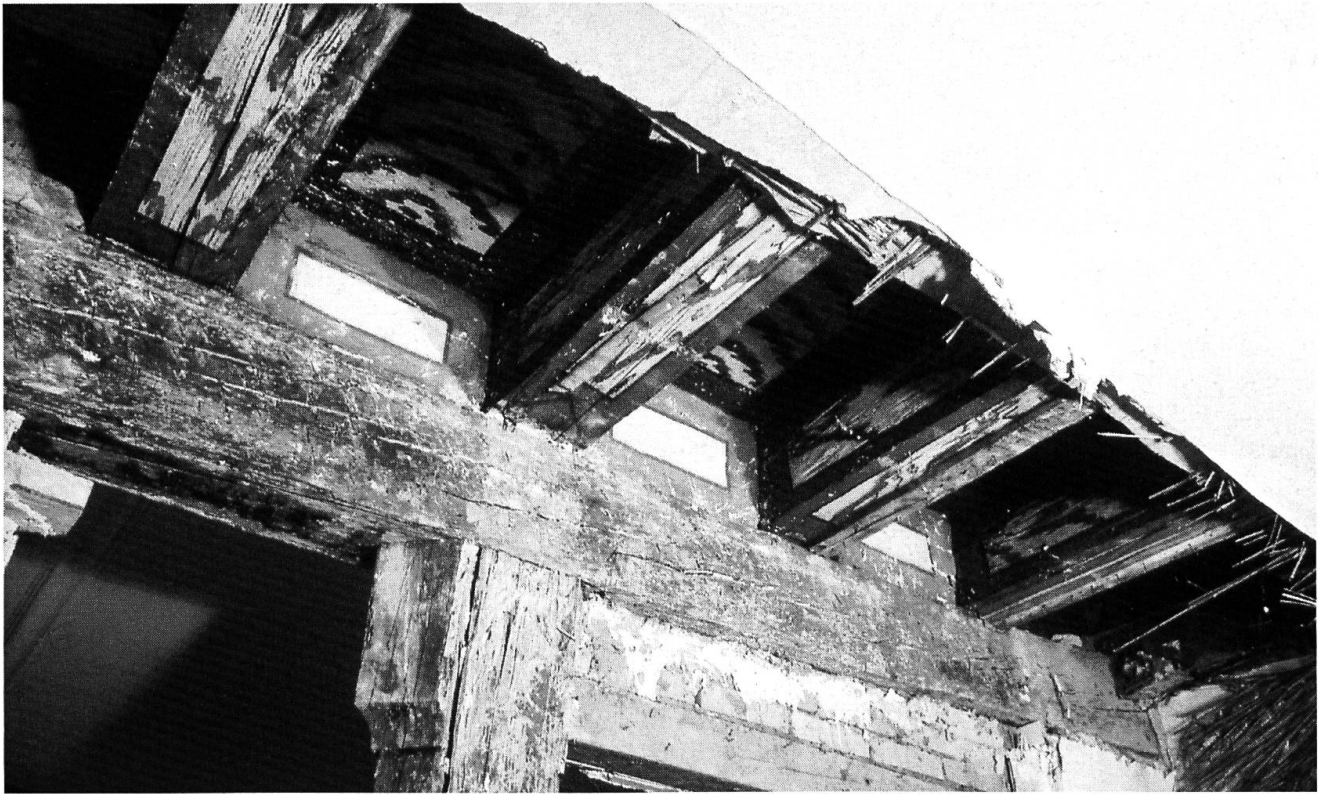
9 Freigelegte bemalte Holzdecke im 3. Obergeschoss.
