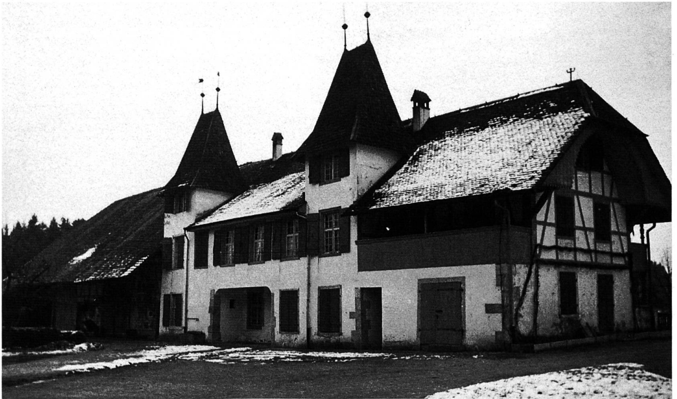
Der Buchhof in Lohn/Ammannsegg. Aufnahme 1951. Archiv Denkmalpflege.
