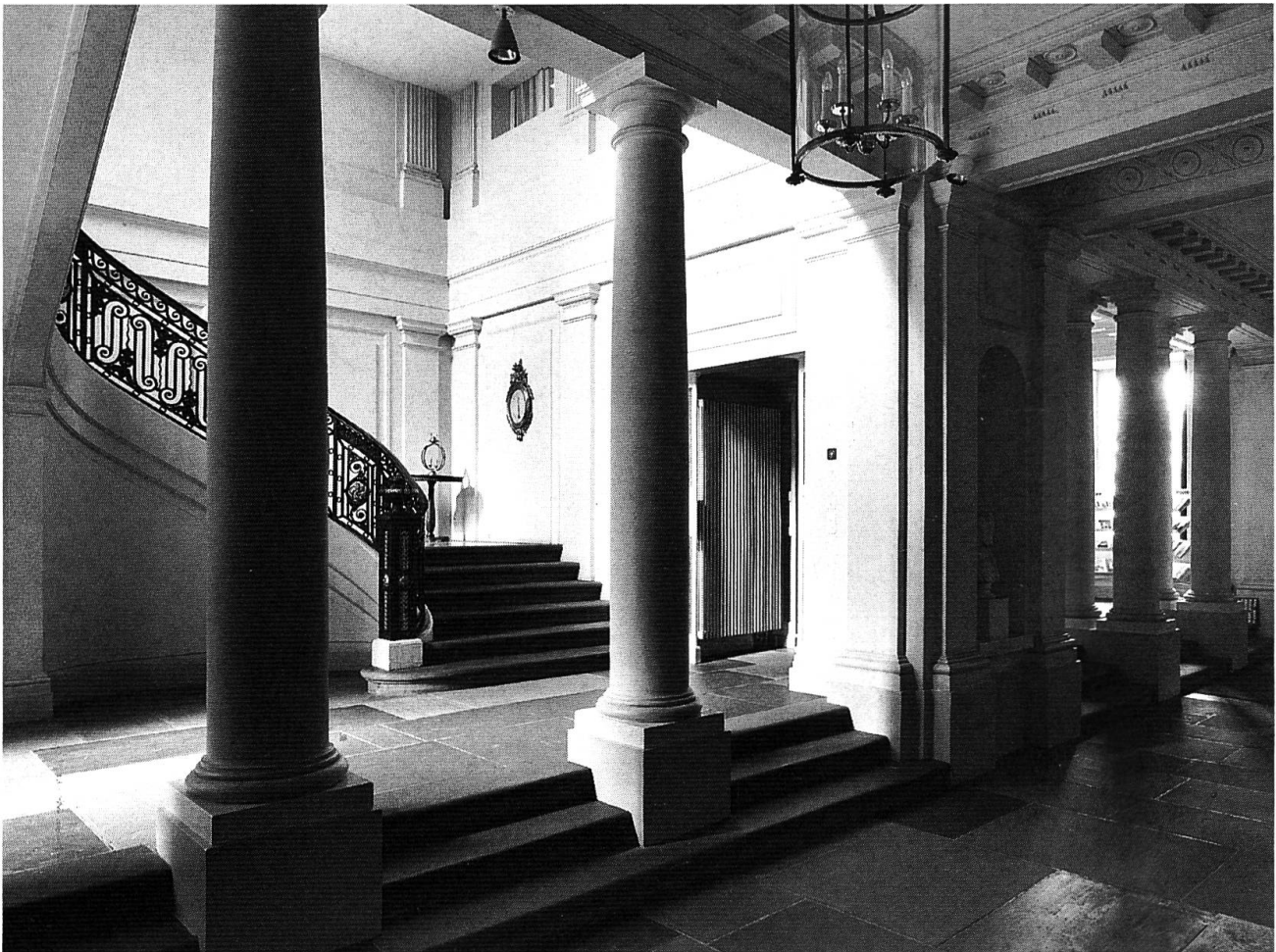
Haus zum Kirschgarten, 1775–1780. Blick in die Erdgeschosshalle.
