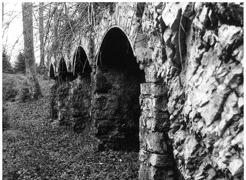
Unterstände der Fortifikation Hauenstein 1914–1918 am Spitzenflüeli. Fotos U. Wiesli
