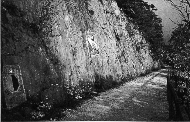
Belchen-Südstrasse mit den Wappen militärischer Einheiten 1914–1918.
