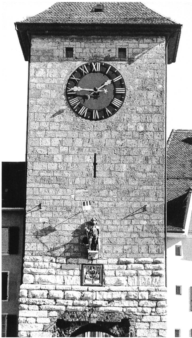
Solothurn, Bieltor: Die Untergeschosse im hellen Solothurner Kalkstein entstammen dem frühen 13. Jahrhundert. Die vier darüberliegenden Geschosse oberhalb der St. Ursenfigur sind aus glatten Tuffsteinquadern gefügt und dürften im späten 14. oder im frühen 15. Jahrhundert aufgeführt worden sein.
