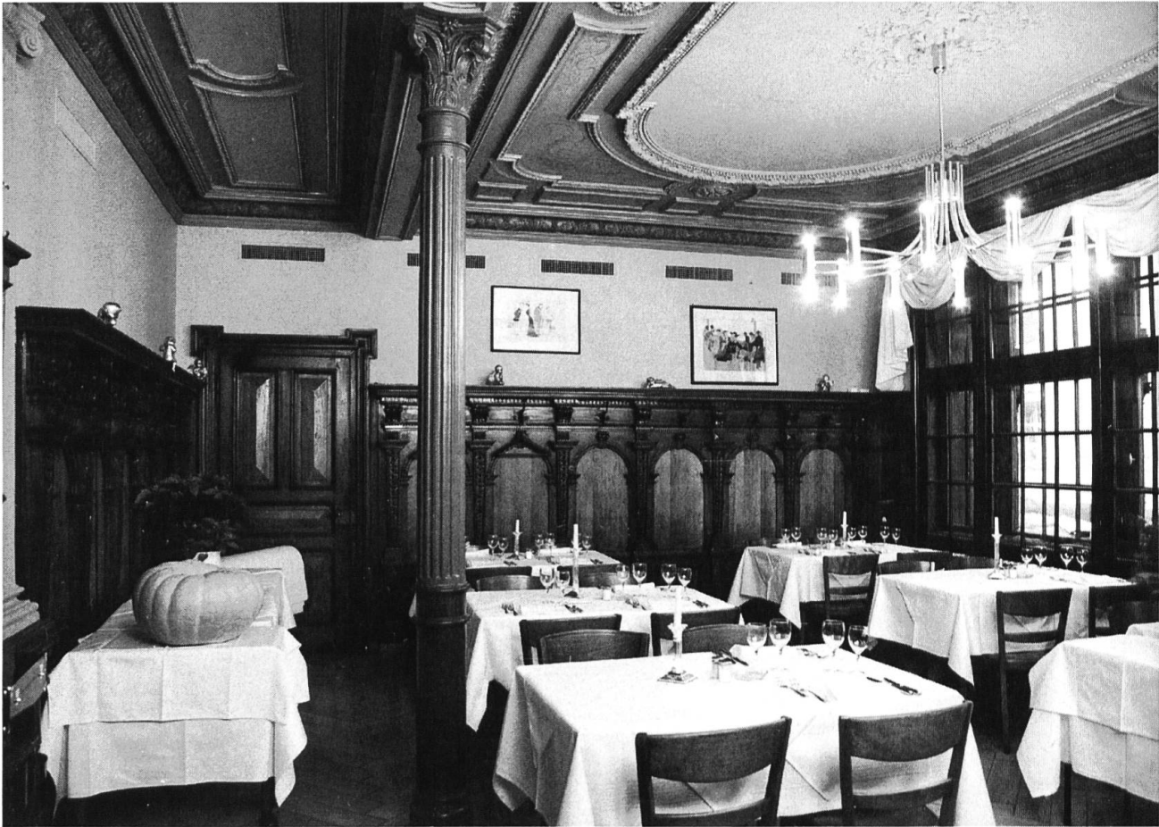
Grenzacherstrasse 60. Restaurant der ehemaligen Brauerei Warteck. Saal mit Täfer und in Ockertönen bemalter Stuckdecke, 1899.
