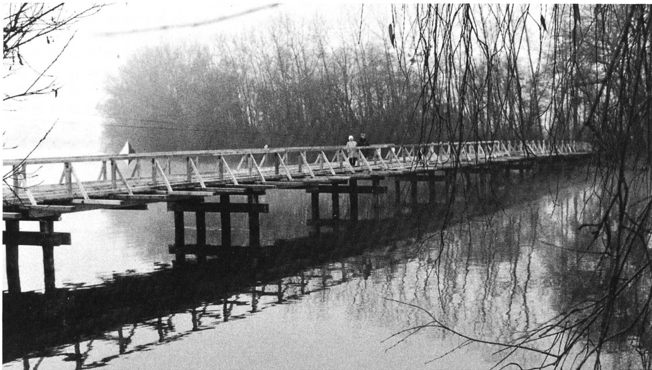
Im Winter 1991/92 wurde auf dem Inseli eine Hofsanierung vorgenommen. Für diesen Umbau hat das Genie Bat 22 innerhalb der Aktion «Gemeinsam» vorübergehend eine Holzbrücke erstellt.
