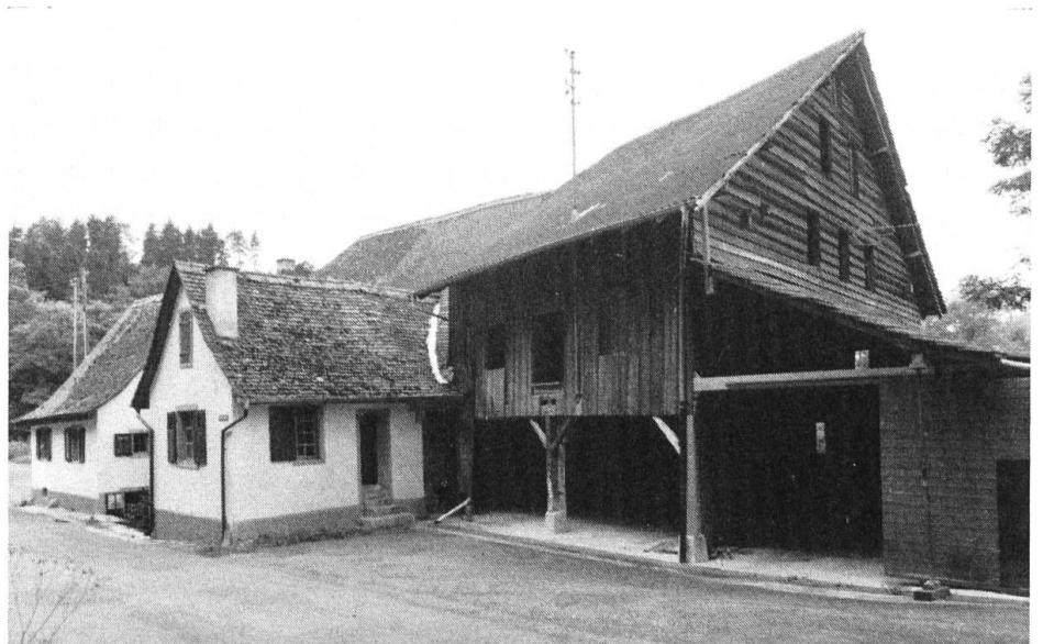
Abb. 3: Ansicht von Osten.
