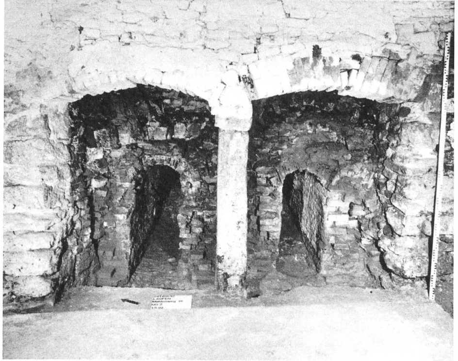
Abb. 6: Die Einf Feuerungs- öffnung des Ofens 2.
