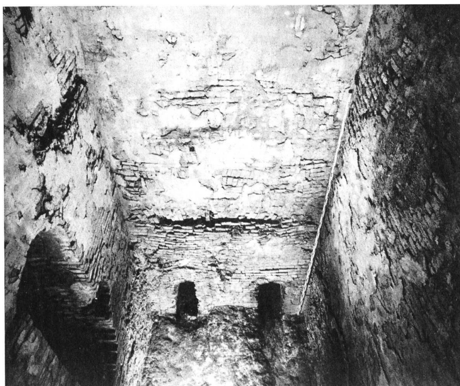
Abb. 5: Einblick von oben in den Brennraum des Ofens 2.
