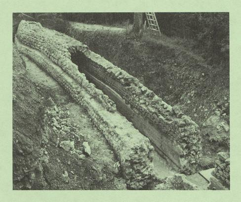
Das freigelegte Stück der römischen Wasserleitung ist ausgezeichnet erhalten. Die untere Hälfte ist mit einem Spezialmörtel abgedichtet, der Kanal von einem Gewölbe überdeckt.
