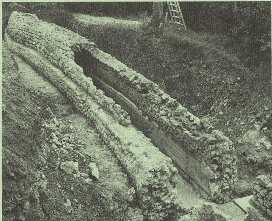
Das freigelegte Stück der römischen Wasserleitung ist ausgezeichnet erhalten. Die untere Hälfte ist mit einem Spezialmörtel abgedichtet, der Kanal von einem Gewölbe überdeckt.
