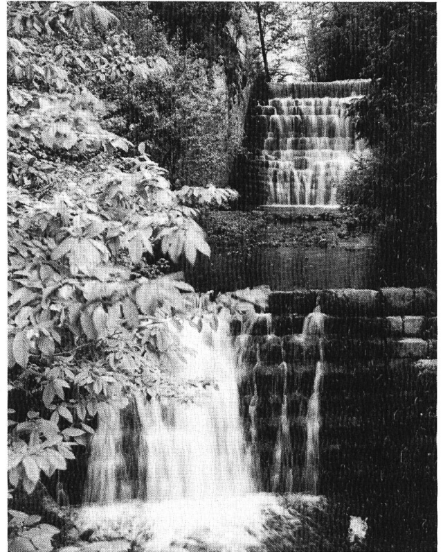
Um den Wildbach zu bändigen, hat man am Hammerrain Schwellen und Stufen eingebaut. In der Nähe des Hofes Hinterer Hammer westlich Herbetswil ist ein Wasserfall entstanden. Foto Peter Hagmann
