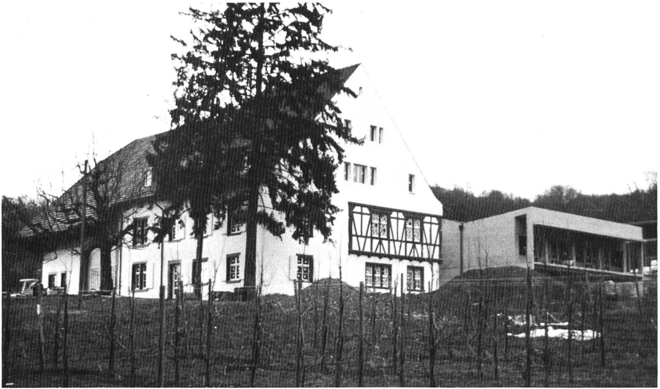
5 Der renovierte Spittelhof heute. Rechts der Verbindungstrakt zu den neu erstellten Bauten. In der Mitte die Reste des Fachwerkhause von 1675/76 umbaut von den Erweiterungen des Jahres 1829. Das Fachwerk der Ostfassade wurde bei den jüngst vorgenommenen Renovationen ausgewechselt. Links aussen die Scheune von 1902. Foto: Autor
