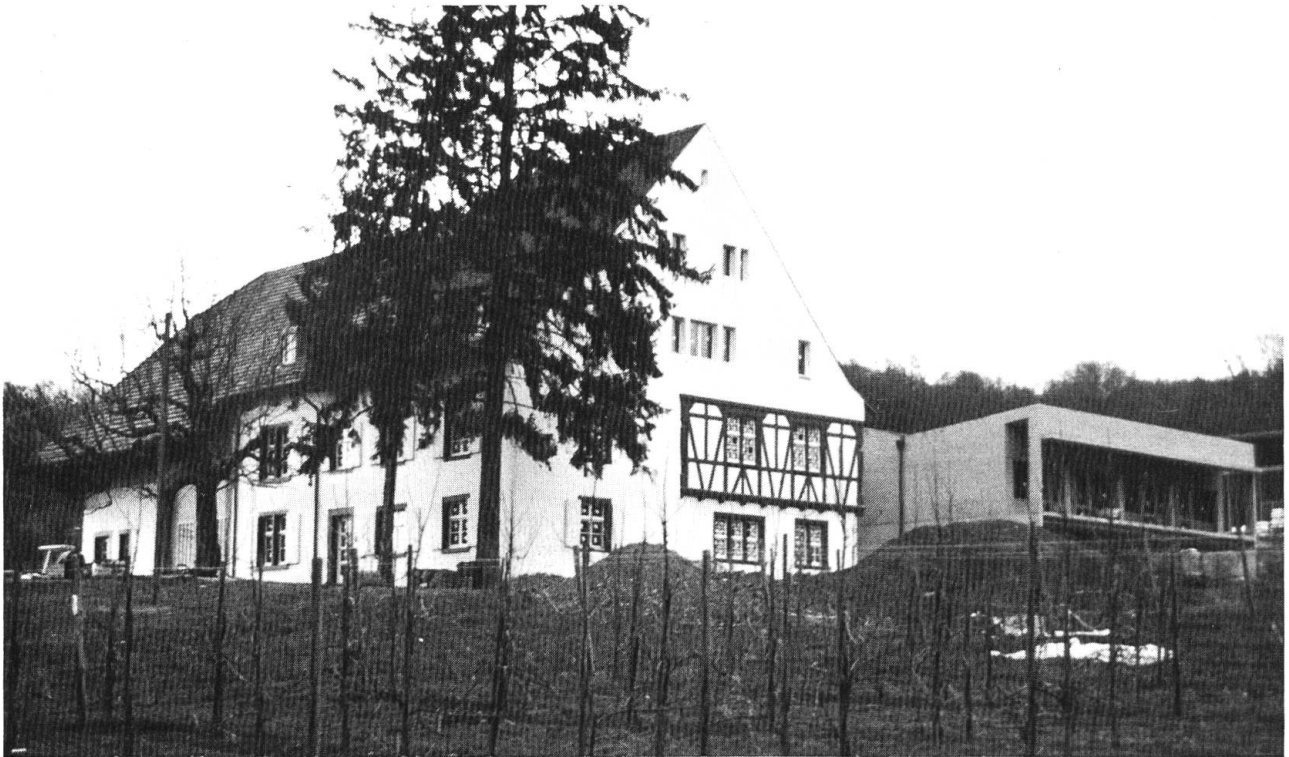
5 Der renovierte Spittelhof heute. Rechts der Verbindungstrakt zu den neu erstellten Bauten. In der Mitte die Reste des Fachwerkhause von 1675/76 umbaut von den Erweiterungen des Jahres 1829. Das Fachwerk der Ostfassade wurde bei den jüngst vorgenommenen Renovationen ausgewechselt. Links aussen die Scheune von 1902. Foto: Autor
