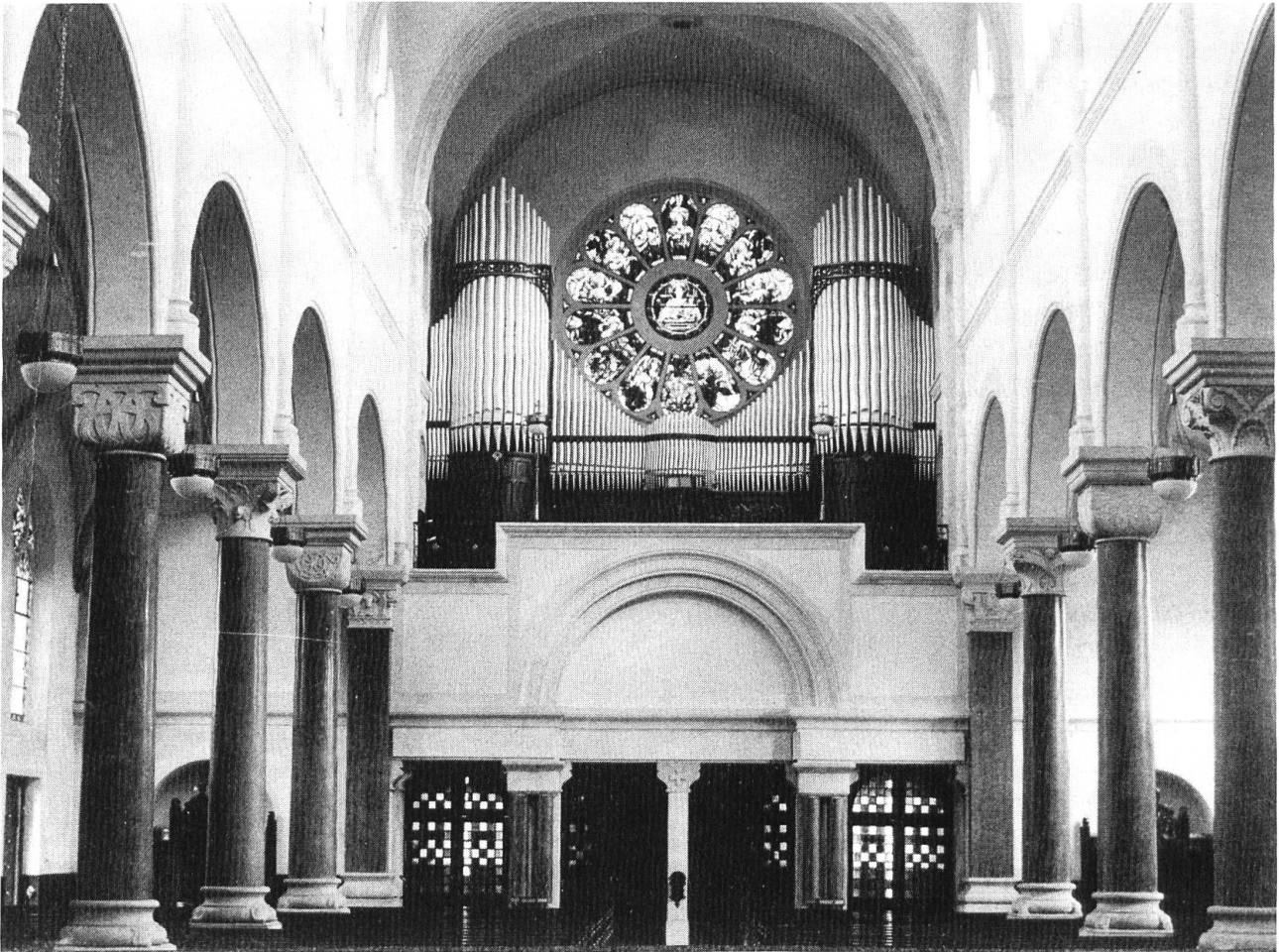
Schon die erste Hauptorgel war, wie dieses Bild zeigt, entgegen allen orgelbautechnischen Prinzipien, um das grosse Rosettenfenster herum erbaut worden. (Foto: StAO)
