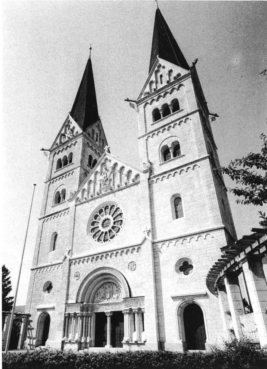
Die St. Martinskirche mit ihren beiden 65 Meter hohen Türmen gehört zu den eindrucklichsten Bauten Oltens. (Foto: Th. Ledergerber)
