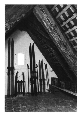
Fläche besteht aus sechseckigen Bodenplatten aus Ton, die eher für vornehmere Böden in Kombination mit quadratischen Bodenplatten gebräuchlich waren; mit eben solch quadratischen Platten ist die Restfläche bedeckt.
