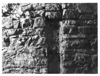
Abb. 9. Negativ eines Holzbalkens von der Unterfangung des Turmes anlässlich der Errichtung der jüngeren Stadtmauer.
