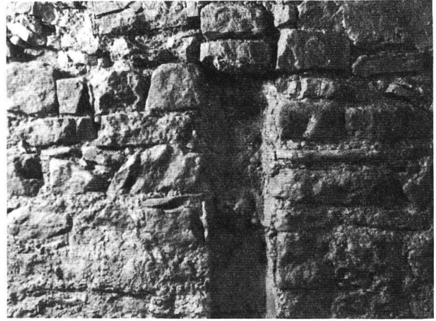
Abb. 9. Negativ eines Holzbalkens von der Unterfangung des Turmes anlässlich der Errichtung der jüngeren Stadtmauer.
