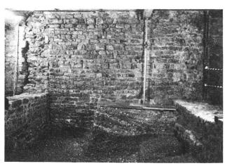
Abb. 4. Anschluss der östlichen Turmwand (Mitte) an die Burkhardsche Stadtmauer (links). Fundament der Südmauer des Turmes (rechts).
