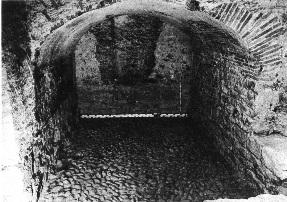
Abb. 1. Keller: Tonnengewölbe mit vorspringender Ecke und Kopfsteinpflasterung.
