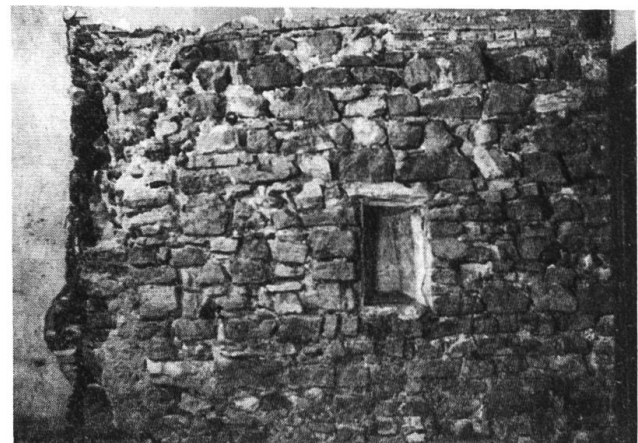
Abb. 6. Schlitzfenster in der östlichen Turmwand, 2. Stock.
