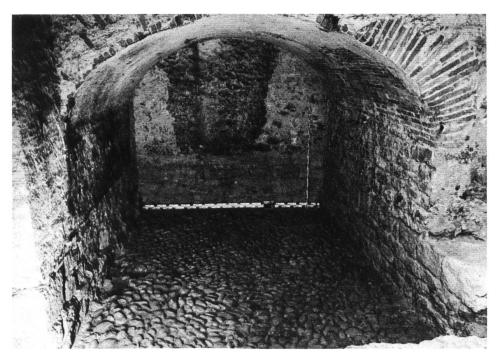
Abb. 1. Keller: Tonnengewölbe mit vorspringender Ecke und Kopfsteinpflästerung.
