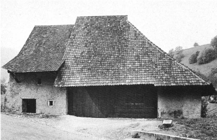
Altes Ständerhaus nach der Restaurierung 1973. Foto: Microfilmstelle BL.
