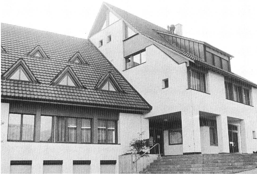
Neue Gemeindeverwaltung im Oberdorf.
