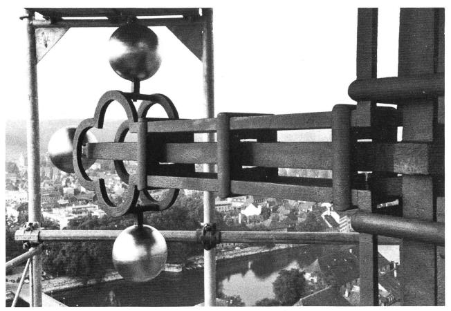
Detailaufnahme: Schnittpunkt der waagrechten und senkrechten Arme. Durchmesser 18 cm, Kantenlänge der Zentralstäbe: 5,2 cm. (Fotos T. Maccaferri 1983).
