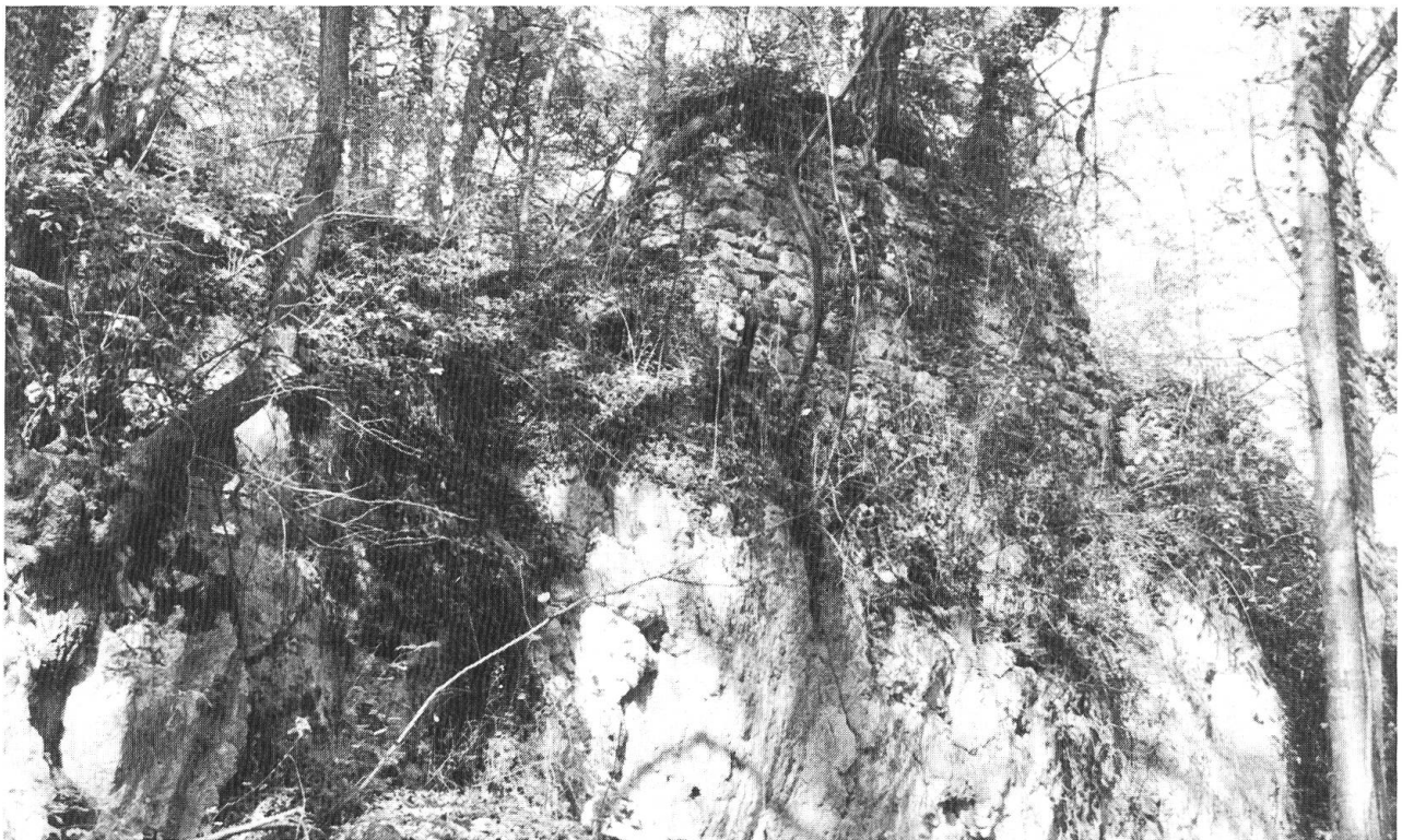
Eine der letzten aufrechtstehenden Mauern.
