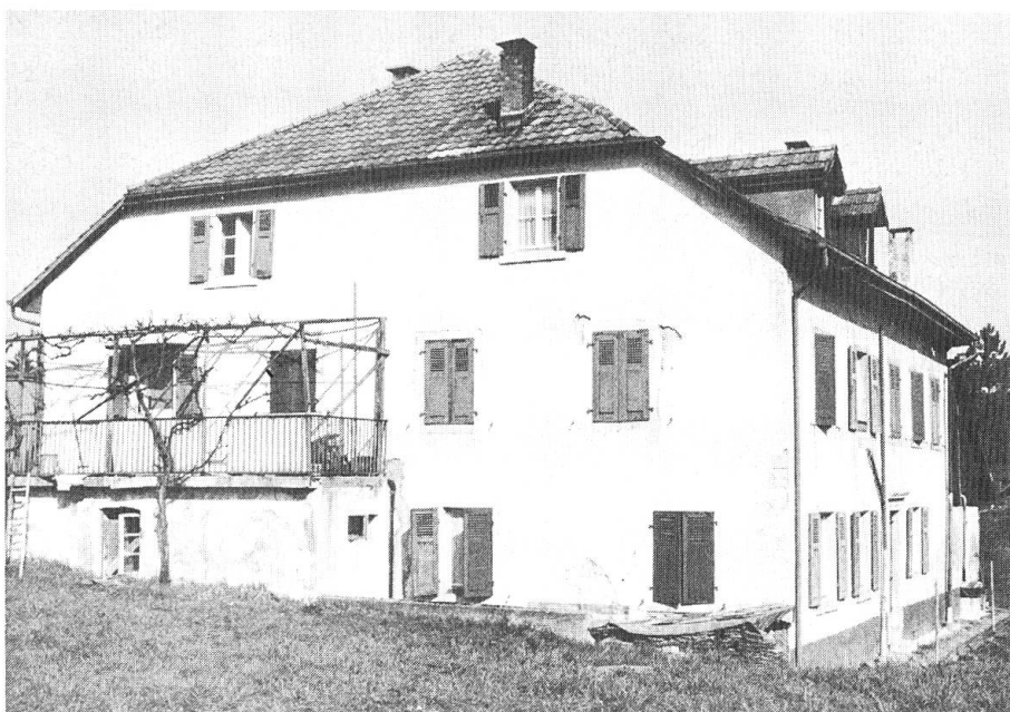
Die alte «Oeli» an der zugedeckten Klusbachmündung in die Birs.
