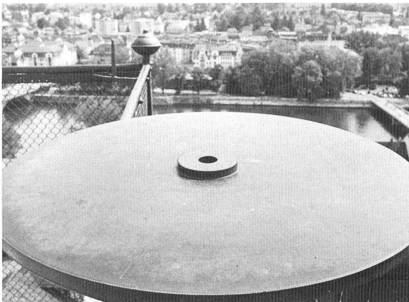
3 Ansicht der Orientierungstafel von Norden. Durchmesser: 52 cm (20 französische Zoll). Zentralwulst mit Loch: 2 cm, Höhe des Wulstes: 1,5 cm.
