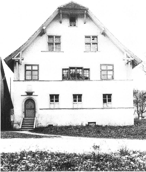
Abb. 3 Wangen b. Olten (Kleinwangen), ehemaliges Untervogtshaus (1643).
