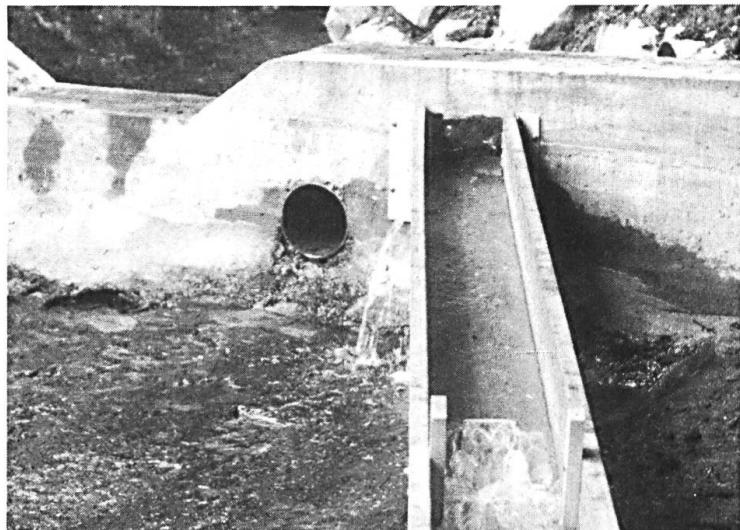
Etwa 200 Meter oberhalb der Grabenöle wird der Mülibach gestaut und ein Teil des Wassers in einen Kanal geleitet, der zur Grabenöle führt.
