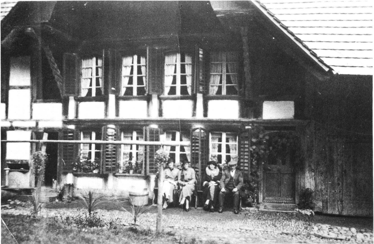
Älteste vorhandene Abbildung der Südfassade (Herbst 1934).
