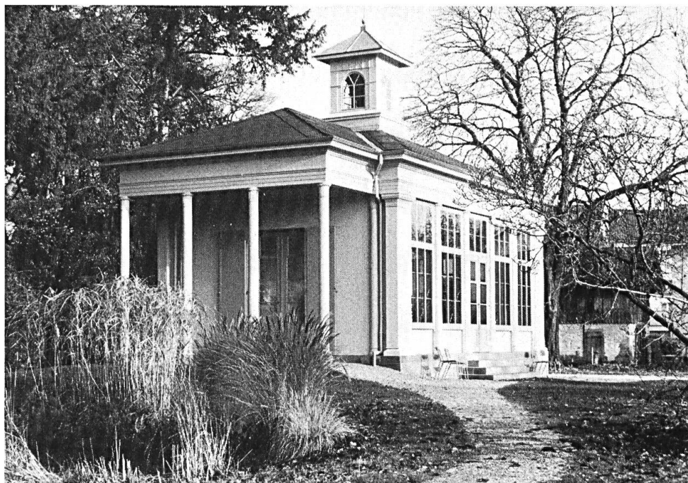
Orangerie des Sarasingutes, Rössligasse 51, Riehen, erbaut 1836. (Foto: Rolf Brüderlin, dipl. Arch., Riehen).
